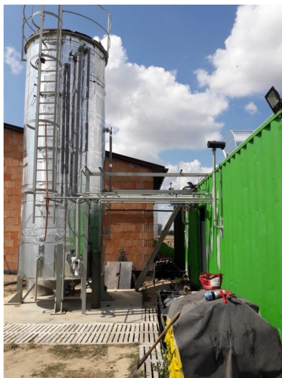
Fot. 4.1. Reaktor przepływowy monosubstratowy do fermentacji metanowej gnojowicy wraz z instalacją do produkcji biogazu -widok
