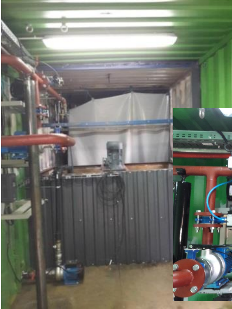
Rys. 17. Elementy instalacji: a) elastyczny zbiornik biogazu, b) układ pomp, c) zbiornik operacyjny z napędem mieszającym, d) mieszadło.
