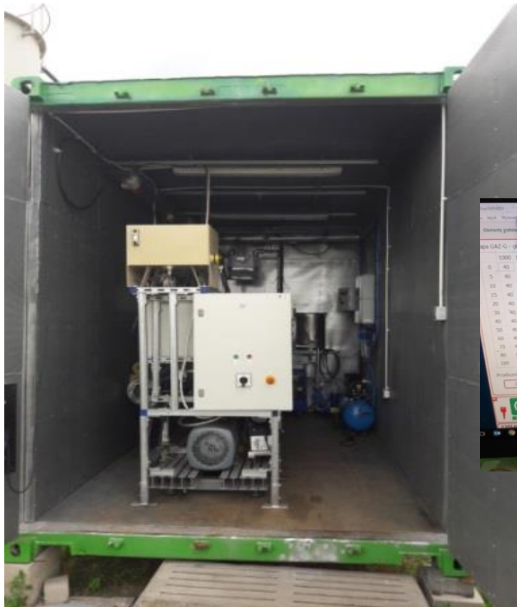
Rys. 31. Kogenerator wielopaliwowy [fotografia G. Wałowski]: a) widok w kontenerze, b) sterowanie - widok , widok po demontażu kogeneratora.
