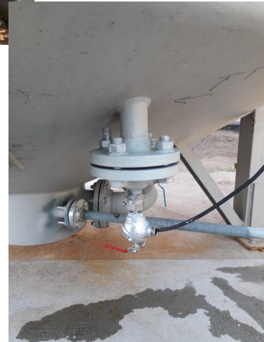
Rys. 16. Zainstalowane urządzenia pomiarowe dla fermentatora - widok: a) ciśnieniomierz biogazu, b) kamertony do pomiaru poziomu wsadu, c) termometry (ściana), d) termometr (dno).
