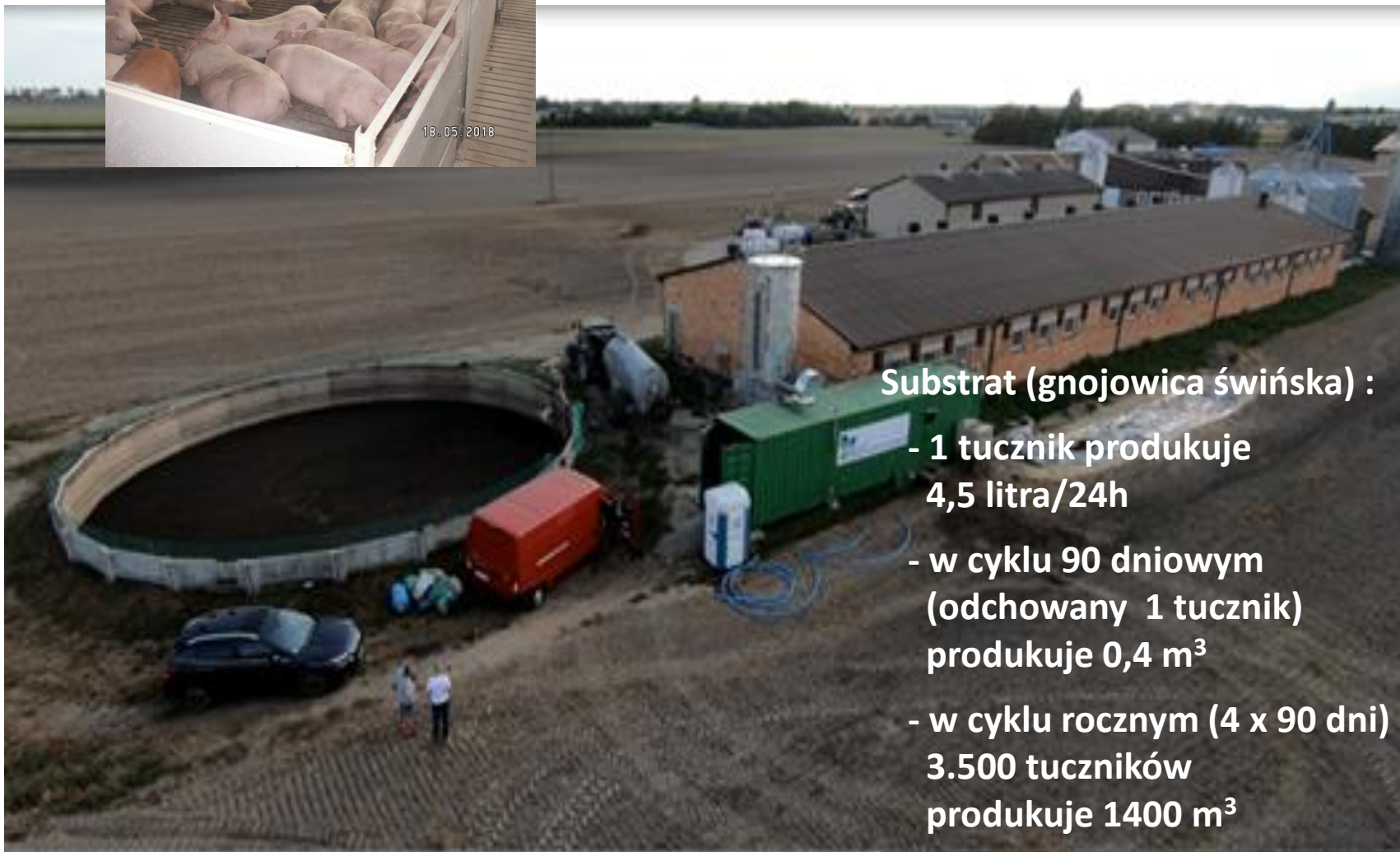
Rys. 10. Składowe zrównoważone systemu gospodarowania i wytwarzania energii dla mobilnej pilotażowej biogazowni kontenerowej: a) producent substratu, b) model konwersji.
