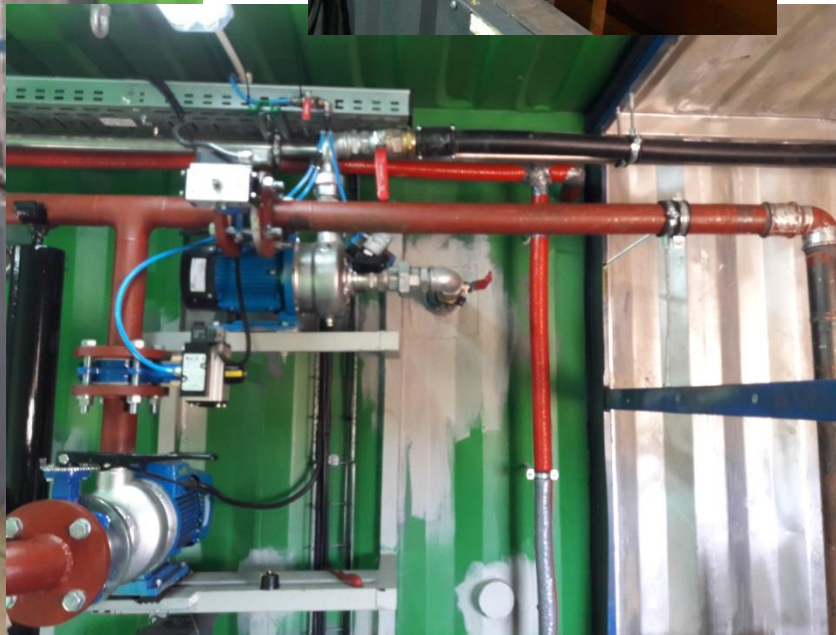
Rys. 17. Elementy instalacji: a) elastyczny zbiornik biogazu, b) układ pomp, c) zbiornik operacyjny z napędem mieszającym, d) mieszadło.
