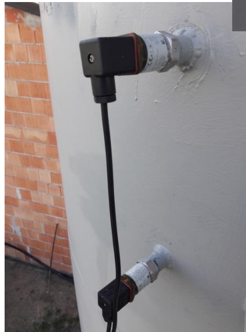
Rys. 16. Zainstalowane urządzenia pomiarowe dla fermentatora - widok: a) ciśnieniomierz biogazu, b) kamertony do pomiaru poziomu wsadu, c) termometry (ściana), d) termometr (dno).
