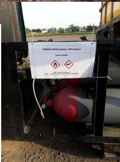
Rys. 20. Rozruch (10 dni) i produkcja biogazu - widok: a) inoculacja, b) mieszanie mechaniczne, c) zbiornik surowego biogazu, d) oczyszczony na rudzie darniowej biogaz sprężony do 100 bar.
