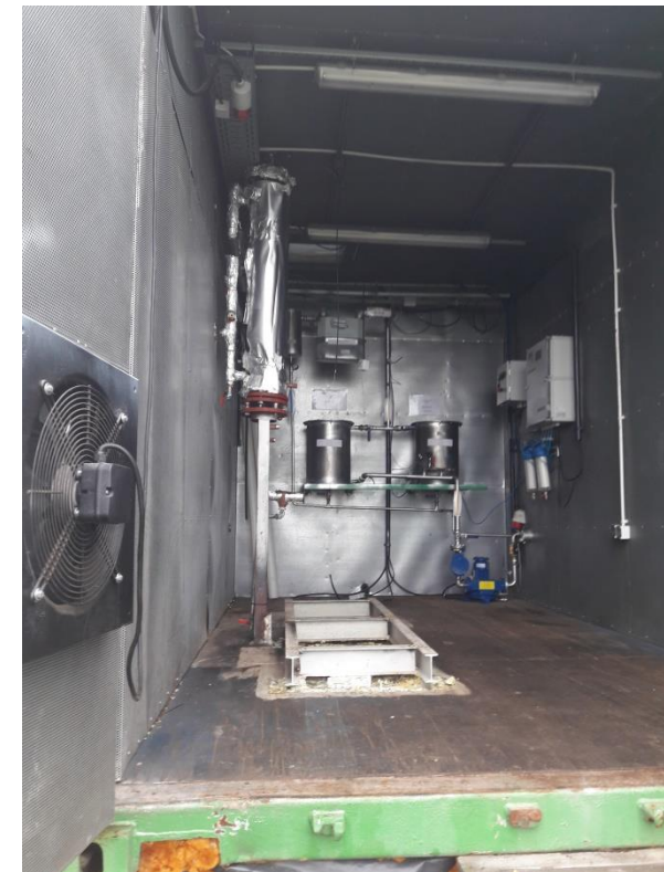
Rys. 31. Kogenerator wielopaliwowy [fotografia G. Wałowski]: a) widok w kontenerze, b) sterowanie - widok , widok po demontażu kogeneratora.
