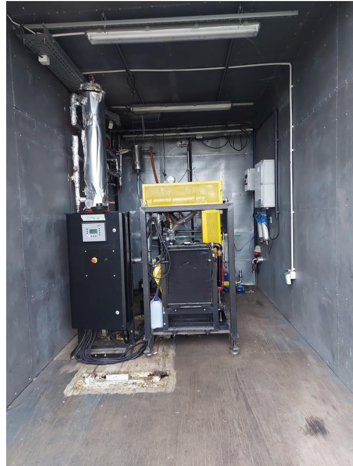
Rys. 32. Kogenerator na biogaz [fotografia G. Wałowski]: a) widok przed montażem, b) widok po montażu.
