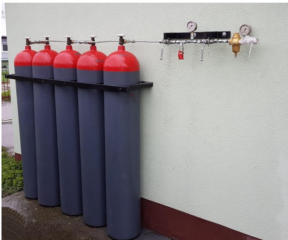
Fot. 3.2. Widok podłączenia butli do zasilania biogazem
