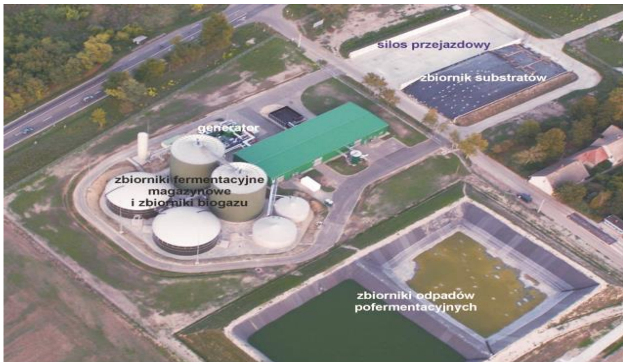
Główne budynki i budowle wchodzące w skład biogazowni
